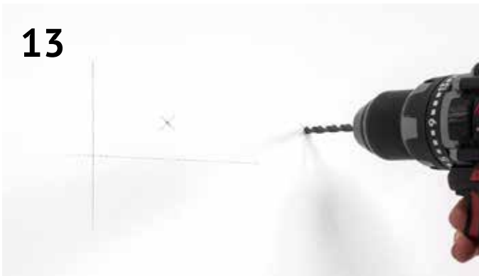
13 Bohren Sie die Löcher und setzen Sie die beiden Dübel ein
