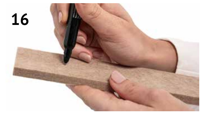
16 Markieren Sie die Bohrpunkte mit einem Stift auf dem Filzabstandhalter
