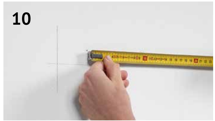
10 Messen Sie einen Abstand von 10 Zentimetern für den zweiten Punkt
