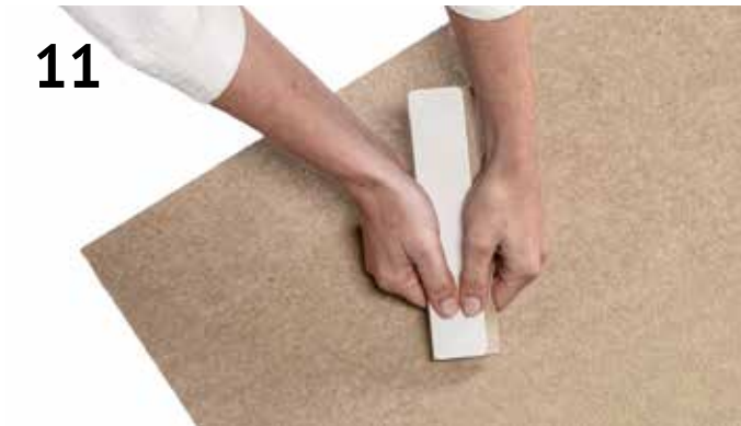
11 Continuez à appuyer fermement pendant quelques secondes pour créer une adhérence très forte (!)
