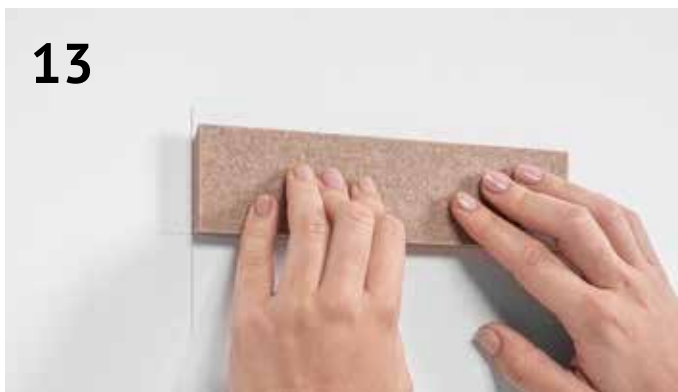
13 Posizionare il distanziatore in feltro nel punto segnato e premere con forza
