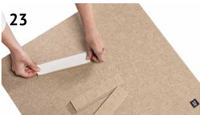
23 Utilizzare il nastro biadesivo in dotazione Consultare prima la scheda tecnica
