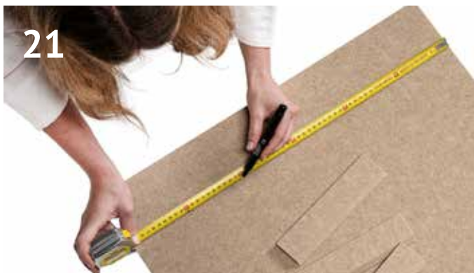
21 Verificare che la distanza tra i due punti sia di 20 cm
