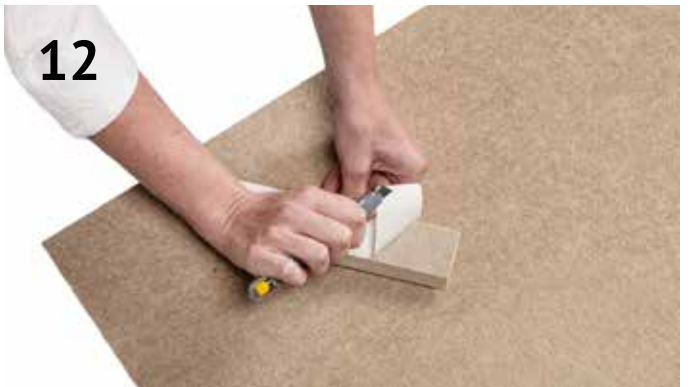
12 Verwijder de beschermlaag van de dubbelzijdige tape
