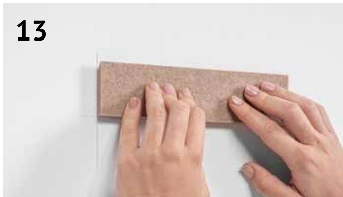
13 Plaats de vilten afstandhouder tussen de twee punten en druk stevig aan
