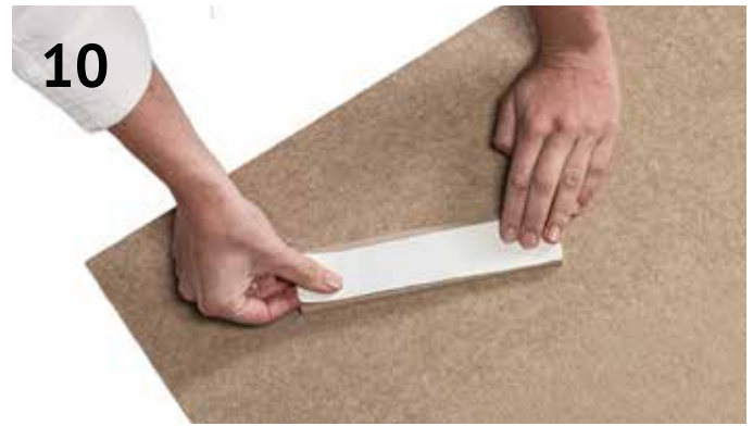
10 Druk stevig aan om de dubbelzijdige tape te bevestigen
