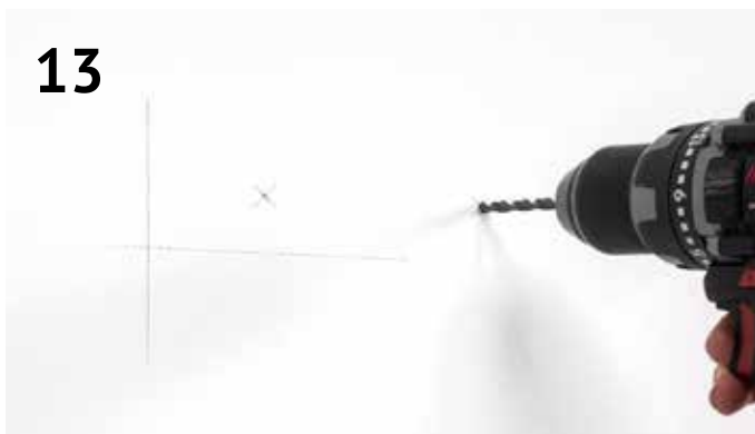
13 Boor de gaten en plaats de twee pluggen Boor de gaten en plaats de twee pluggen
