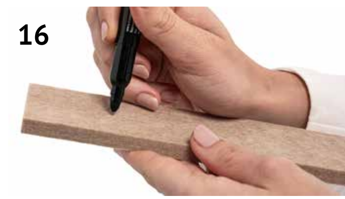
16 Gebruik een stift om de boorpunten op de vilten afstandhouder te markeren
